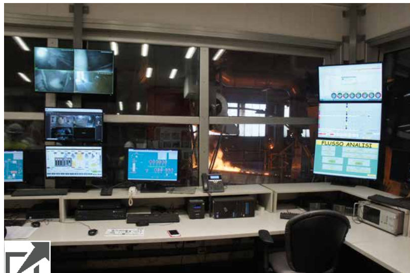
Рецептура литейного чугуна контролируется компьютерной системой
